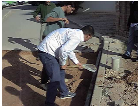
Photo n° 2 : Coffrage de la planche d'essai
