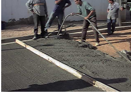
Photo n° 4: Vibration du béton
