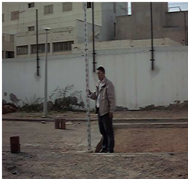
Photo n° 1 : Préparation de la plate forme
