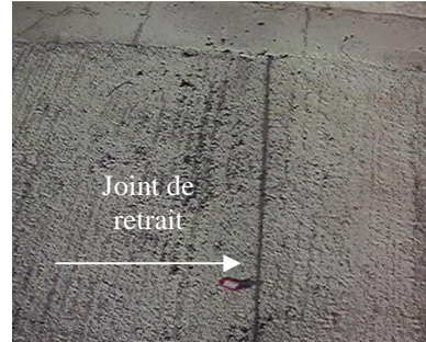
Photo n° 5: Joint de retrait finie
