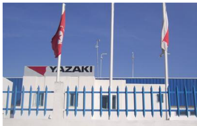
Ateliers de câblage pour automobiles YAZAKI à Gafsa
