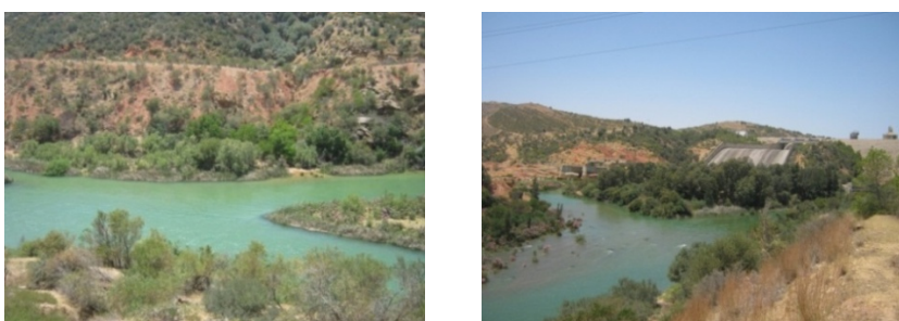
Barrage de Sidi Salem (Sommre 2013)
